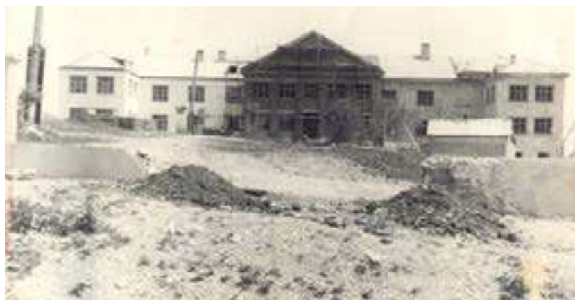
Рисунок 3. Идёт пристройка к школьному зданию 1953–1954 гг.
